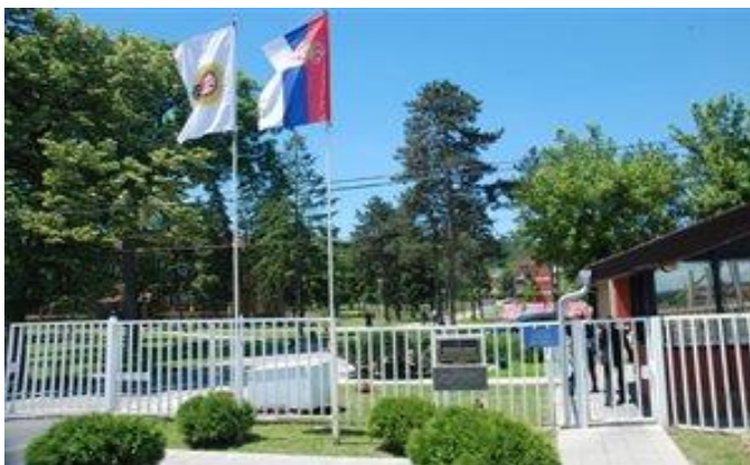
Слика 3. Васпитно поправни дом у Крушевцу – улазна капија и ограда
